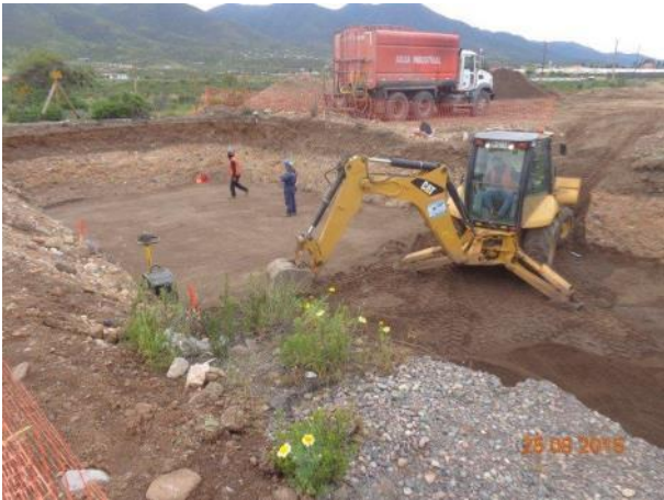
Excavacion Cajon Prefabricado
