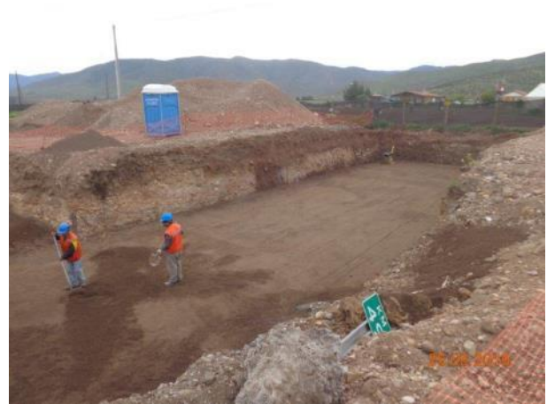
Excavacion Cajon Prefabricado
