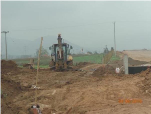
Trabajos O.A. tramo 2.
