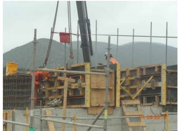
Moldaje estribo Puente La Laguna.
