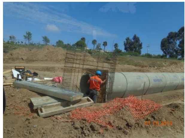
Construccion Muro de Boca OA.
