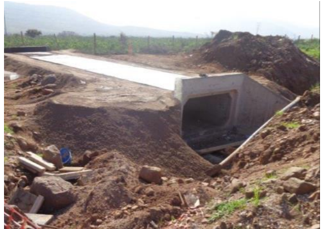
Trabajos Cajon prefabricado tramo 2.
